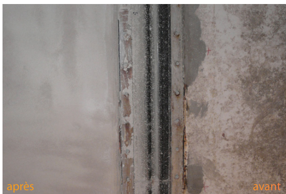
La paroi de la galerie carrée avant et après application du mortier
