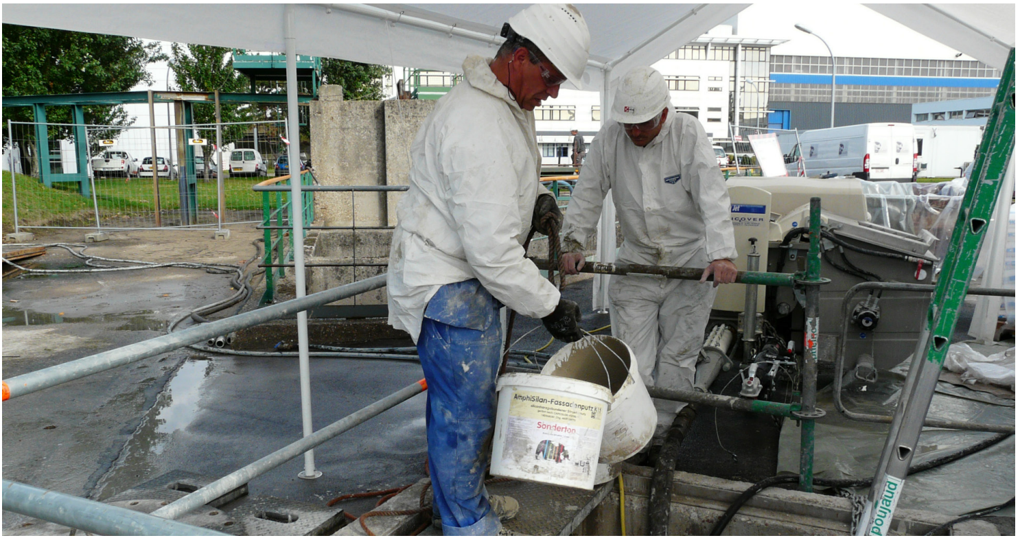
La pompe projette le mortier à une pression de 50 bar
